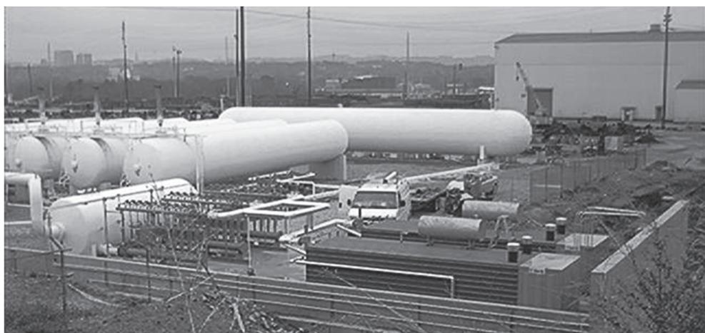
Рис. 6.1. Смесительная система производства Algas-SDI и парк хранения СУГ, используемые для газоснабжения населенного пункта в США. Установка производит 21 тыс. м<sup>3</sup>/ч синтетического натурального газа, Р<sub>вых.</sub> — 0,055 МПа
